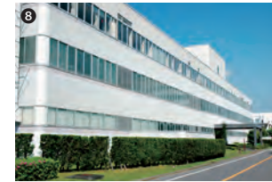
1991 (平成3)年 航空電機工場 (伊勢)
