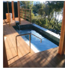
管工事(温浴施設)
