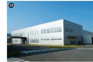
2007 (平成19)年 クリーン搬送機器工場 (豊橋)
