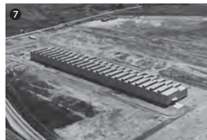
1965 (昭和40)年 豊橋工場建設時
